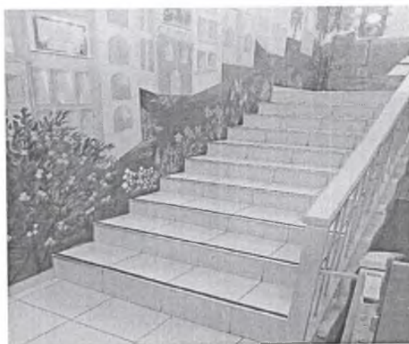
Фото № 15 Лестница на 2 этаж правое крыло
