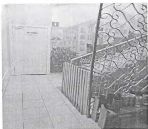
Фото № 14 Лестница на 2 этаж правое крыло
