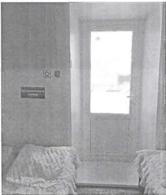
Фото № 9 Эвакуационный выход
